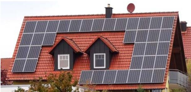
*Photovoltaik-Modul. Die Dachränder sollten auf mind. 0,60 m frei bleiben, damit das Dach als Bauteil noch erkannt wird.*
