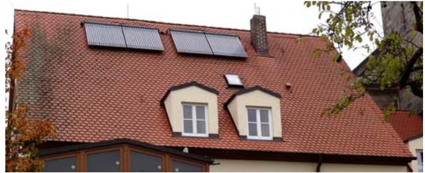
*Photothermie- / Solarthermiezellen zur Warmwasseraufbereitung*
